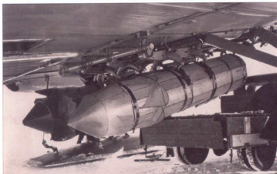
На замках бомбодержателей два агитационных контейнера калибром 1000 кг. Слева - металлический РРАБ-500, справа - деревянный РРАБ-400. Оперение на обоих сложено в положение для транспортировки.
