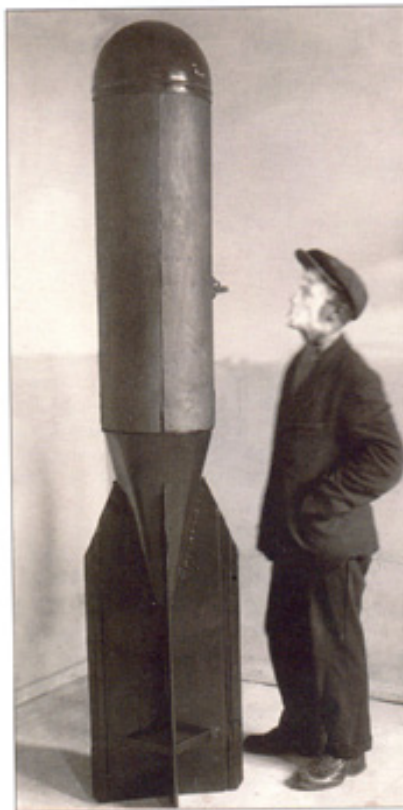
Агитационная авиабомба варианта №6 (что же, что и пятый вариант, но в габарите в ФАБ-250) с раскрывающимся корпусом из фанеры конструкции УБАА ГАУ разработки интенданта 1 ранга Зандера.
